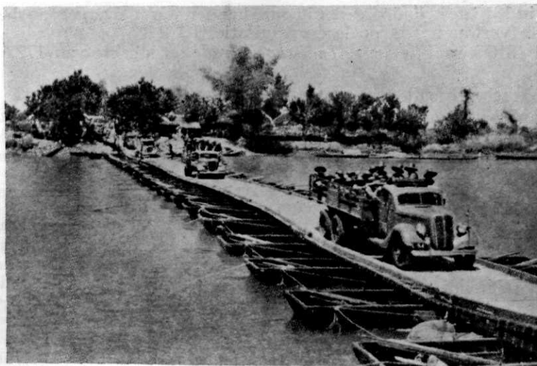
Pontonbrug over de Solorivier.
