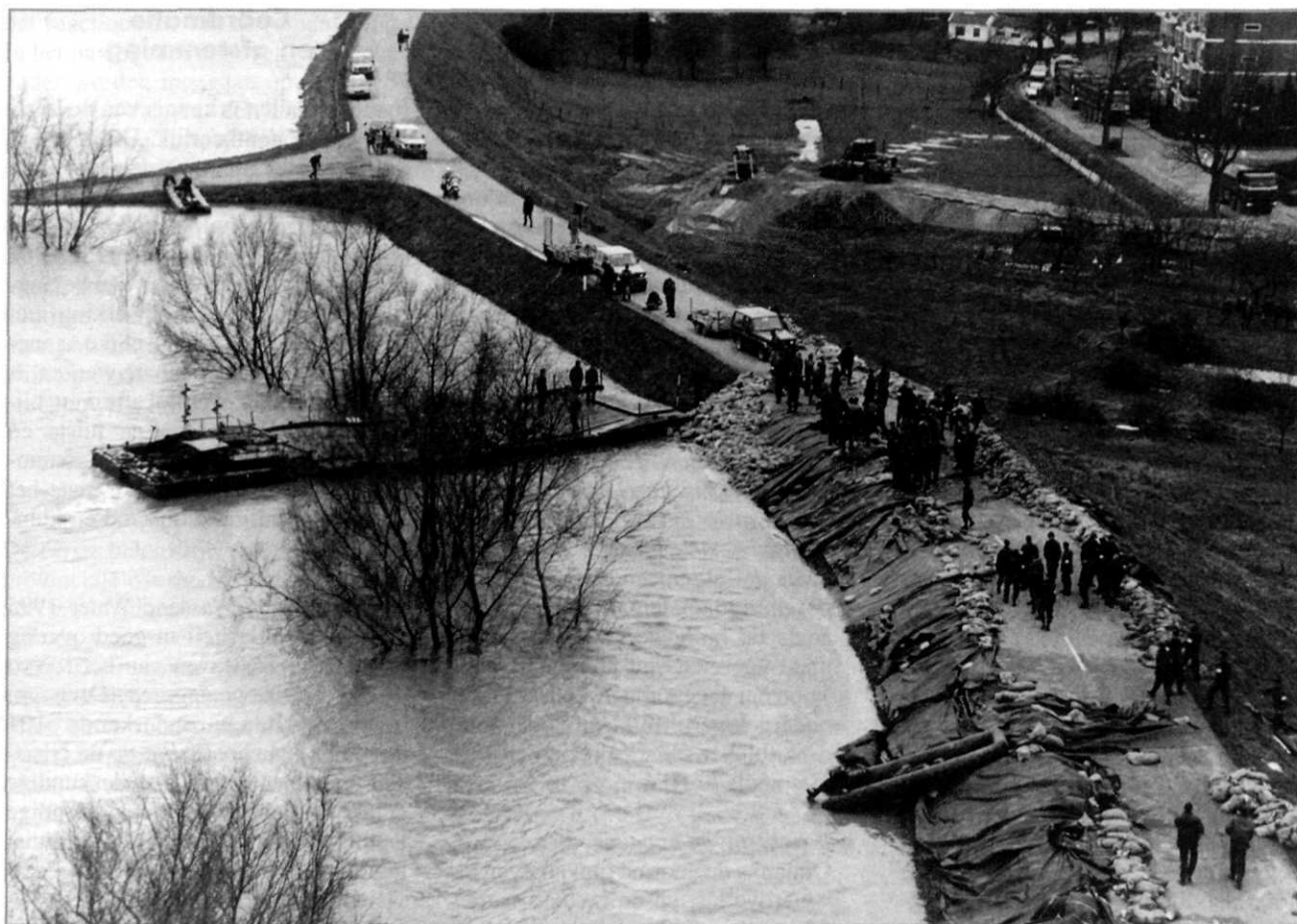
Afb. 3 Het bekleden en het verzwaren van het dijklichaam nabij Ochten (foto: AVDKM)
