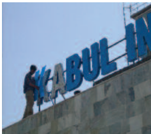
Renovatie van de passagiersterminal. Kabul International Airport, 2007
